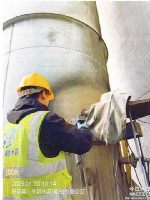
DA149 煤磨废气排气筒采样口◎9
