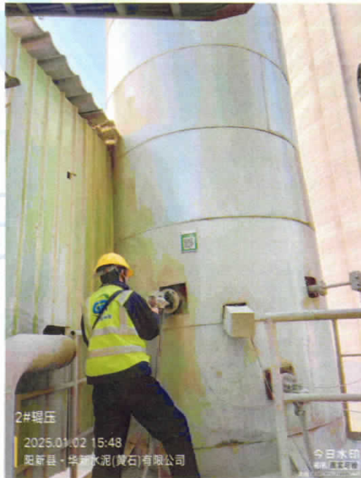
DA146 2#水泥磨辊压机废气排气筒采样口◎8
