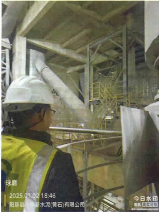
DA148 2#水泥磨球磨机排气筒采样口◎5
