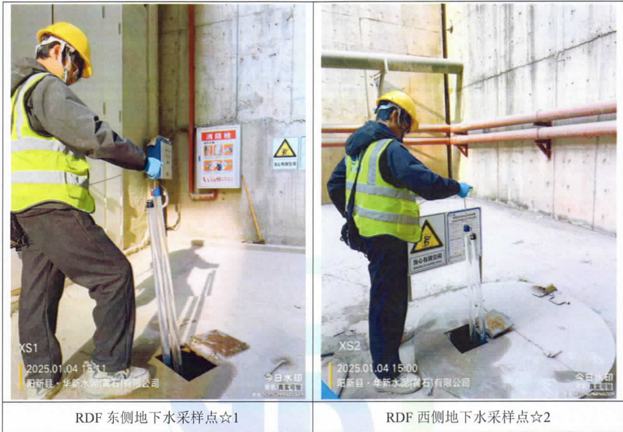
附图 2：现场检测照片
