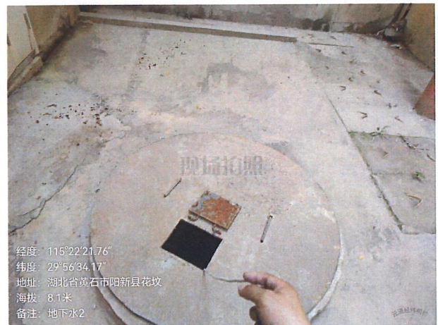
RDF 地下水 2#地下水检测点位
