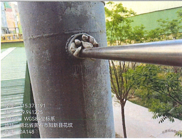
2#水泥磨球磨机排放口 DA148 有组织排放废气检测点位
