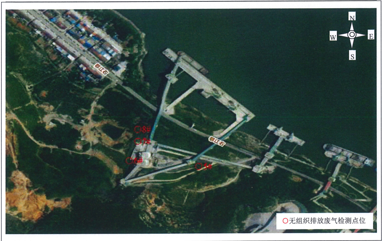
附图：现场检测照片
