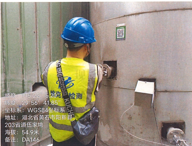
2#水泥磨辊压机排放口 DA146# 烟气在线比对检测点位
