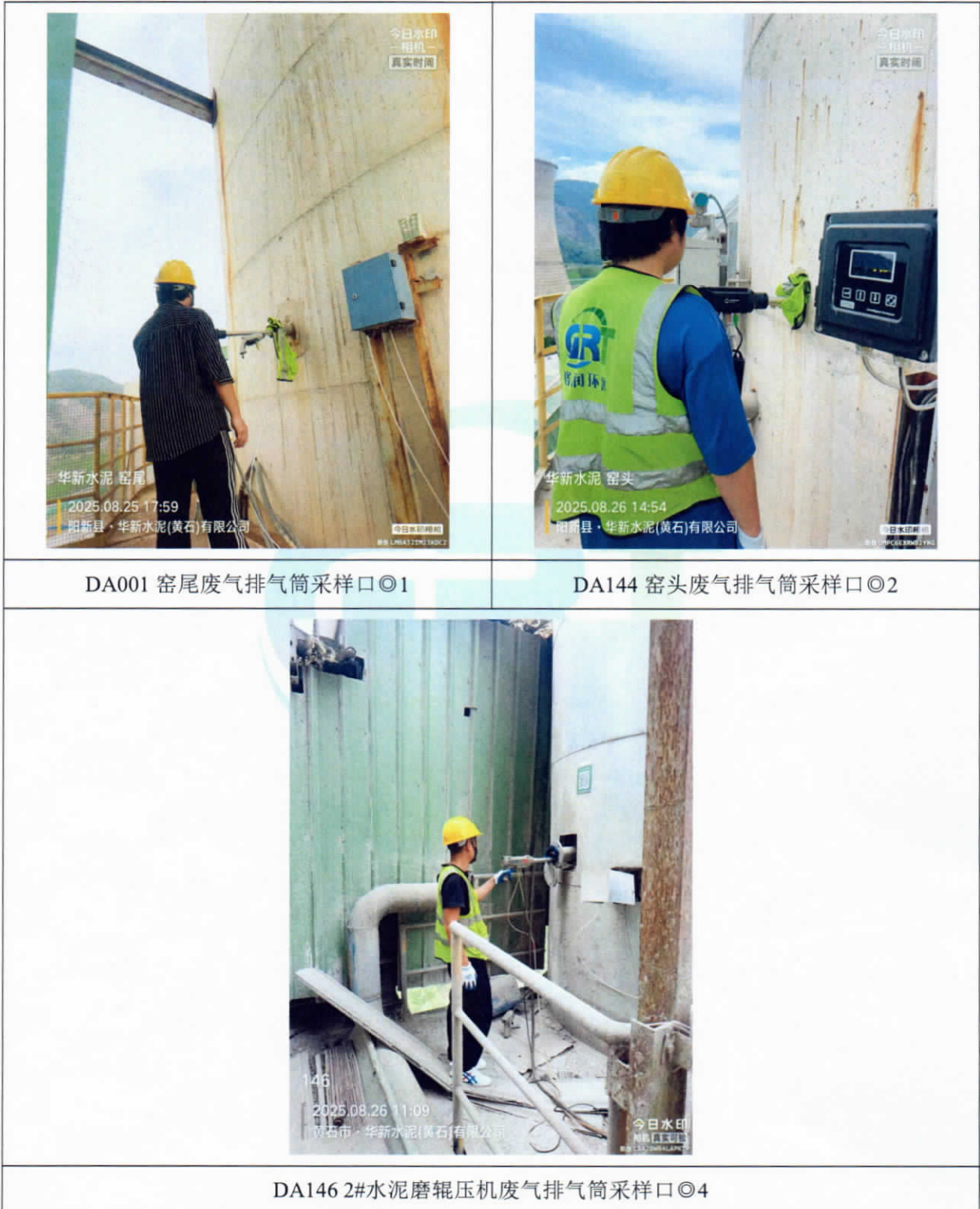
附图 2：现场检测照片
